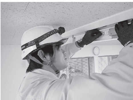
照明器具取付の様子
