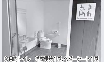
多目的トイレ 洋式便器1基、ベビーシート1基
