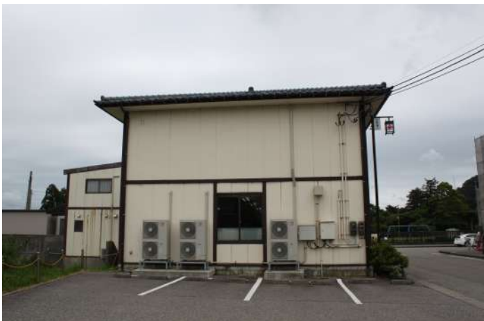
補助対象外工事(西面)
