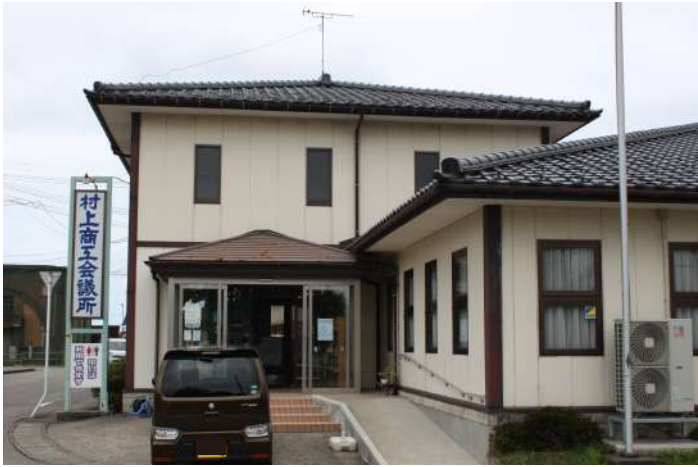
補助対象候補工事(東面)
