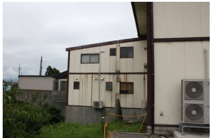
補助対象外工事(西面)
