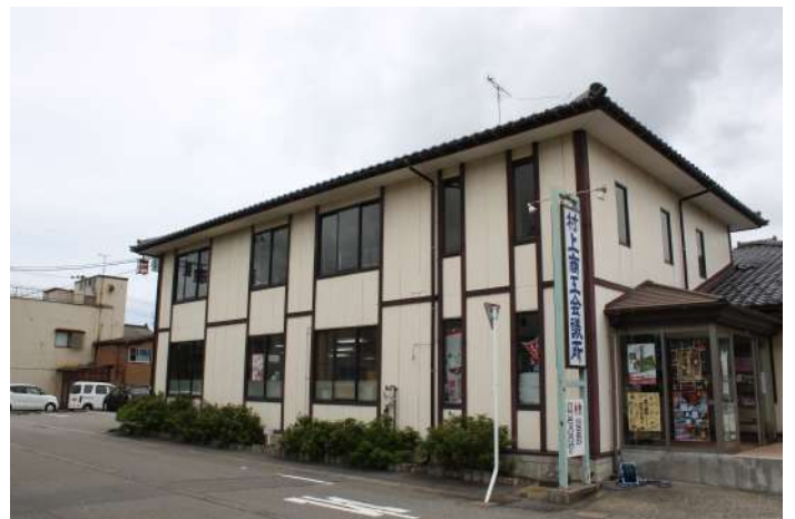
補助対象候補工事(南面)
