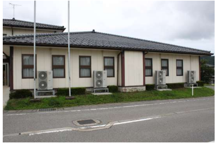
補助対象候補工事(東面)
