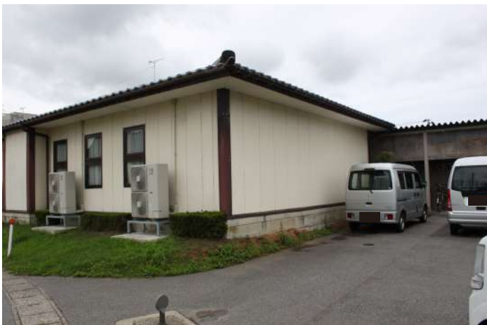
補助対象候補工事(北面一部)
