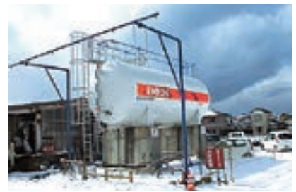
LPガス充填所
