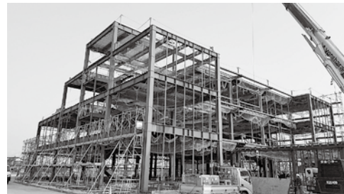
現場での建築風景
