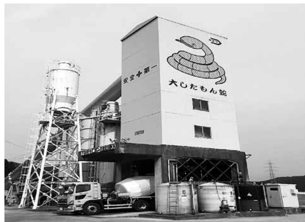
生コンプラント
